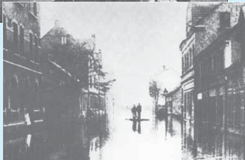
Hochwasser in der Devensstraße in Horst-Süd. Ein seltenes Zeitdokument aus dem Jahre 1909.
