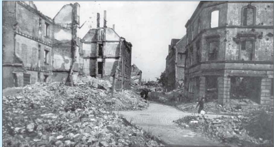
Zerstörter Straßenzug in Gelsenkirchen
